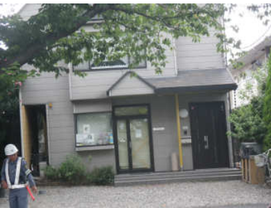
液状化で傾いた住宅(今川地区)
